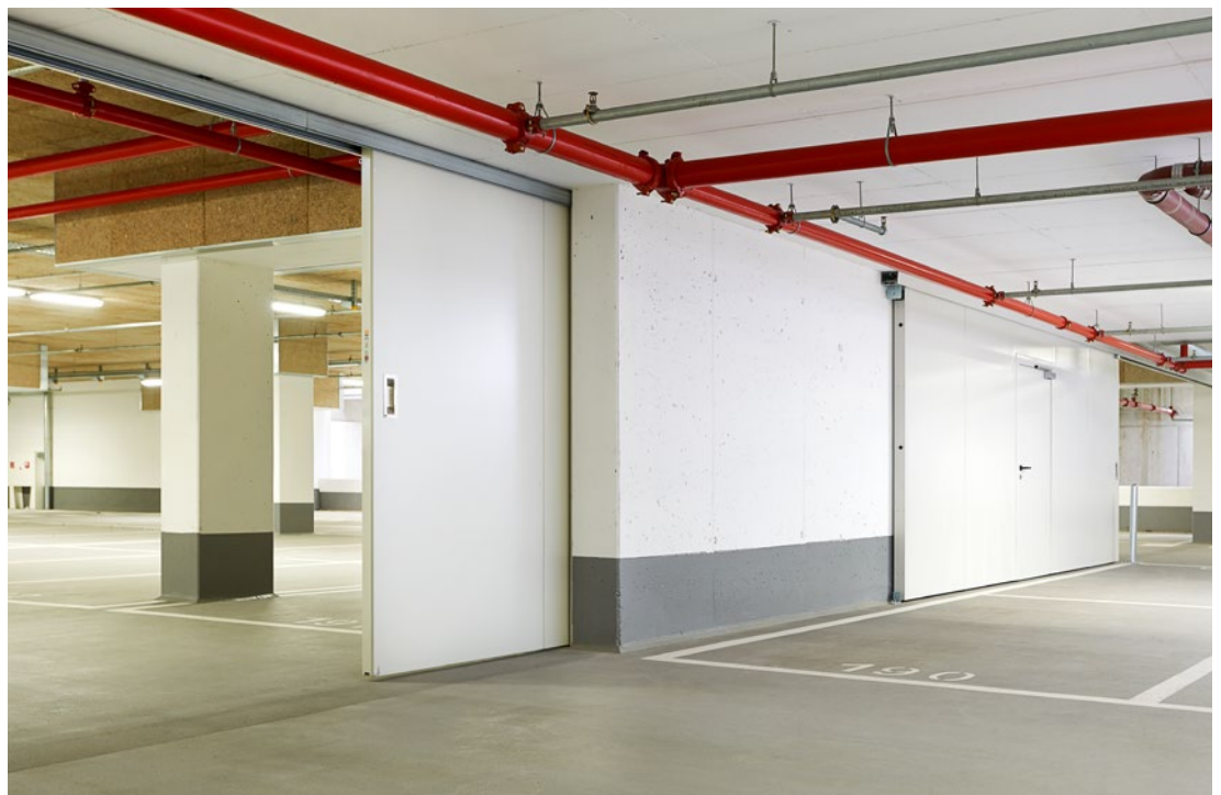
LINKS. Feuerschutz-Drehflügeltor DFT 30-1, 1-flüglig, Verkehrsweiß RAL 9016
